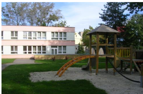
Mateřská škola Čáslavská
