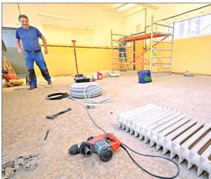
Modernizace dílen ZŠ ČSA začala stavebními úpravami. Foto: Pavel Čempěl
